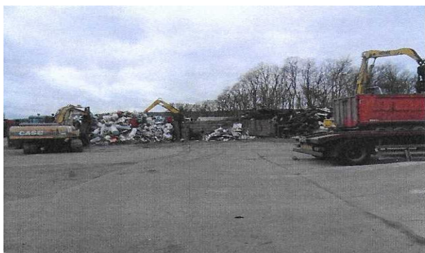
Plateforme principale de stockage (métaux ferreux)
